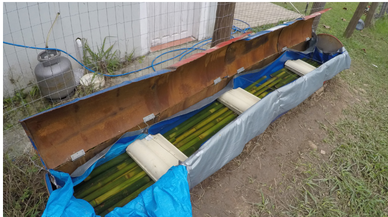
Figura 04: tratamento por imersão em tanque para confecção de protótipo na UFSC. Foto: Vitor (2018).
