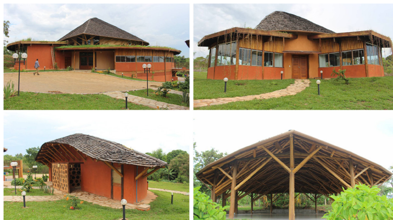
Figura 03: Centro de educação SINPRO, Distrito Federal. Fonte: Arq. Sérgio Pamplona e Eng. Frederico Rosalino.
