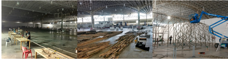
Figura 14: Fabricação e montagem das estruturas. Fonte: Celina Llerena, 2018.
