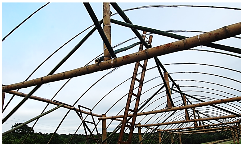
Figura 09: Uso de colmos de bambu gigante e P. aurea na construção de estufa, Pato Branco-PR. Foto: Ostapiv (2016)
