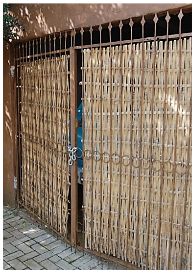
Figura 04: Uso de esteiras trançadas de bambu nativo Guadua trinii , Pato Branco – PR. Foto: Ostapiv (2017)
