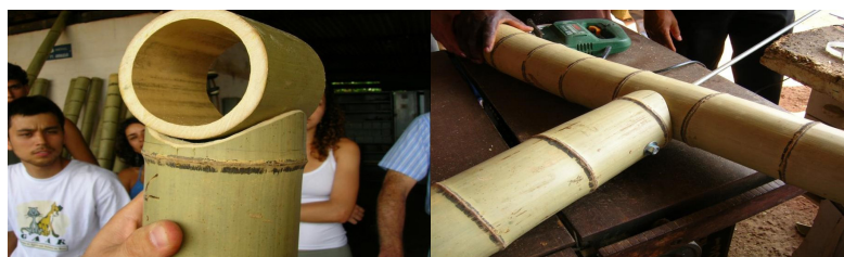
Figura 18: Detalhe da ligação boca-de-peixe; colocação da barra rosqueada.
