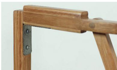
Figura 06: Andador-curvado -detalhe conexão
