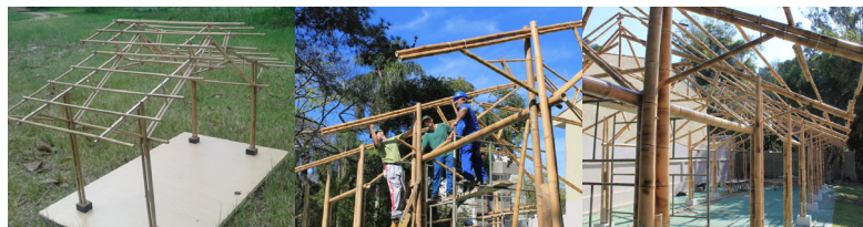
Figura 29: Estudo em maquete da estrutura e sapatas. Fonte: Luciano de Almeida, 2018.
