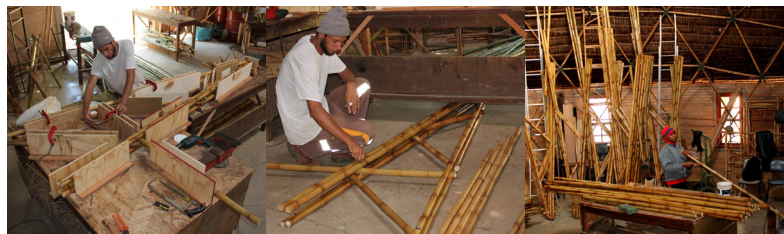
Figura 26: Pré-fabricação dos elementos estruturais. Fonte: Cerbambu Ravena, 2018.
