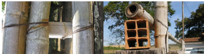
Figura 17: Exemplo de ligações inadequadas entre os colmos de bambu.
